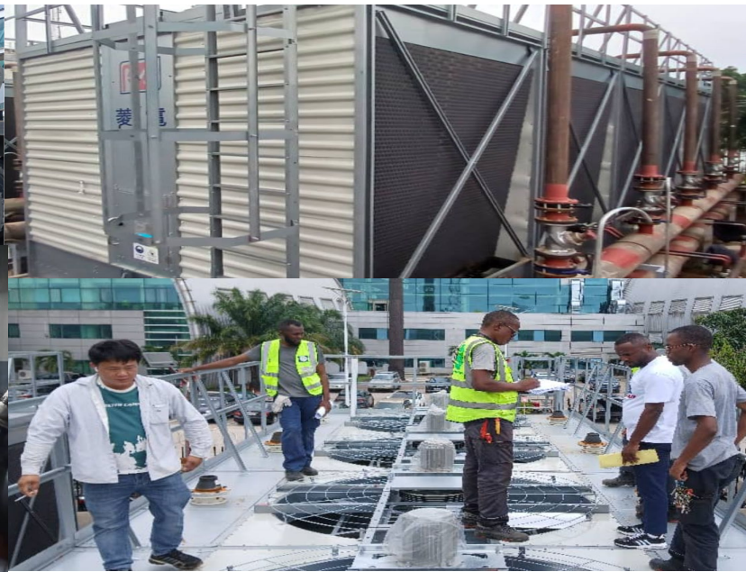
Remplacement tours de refroidissements
