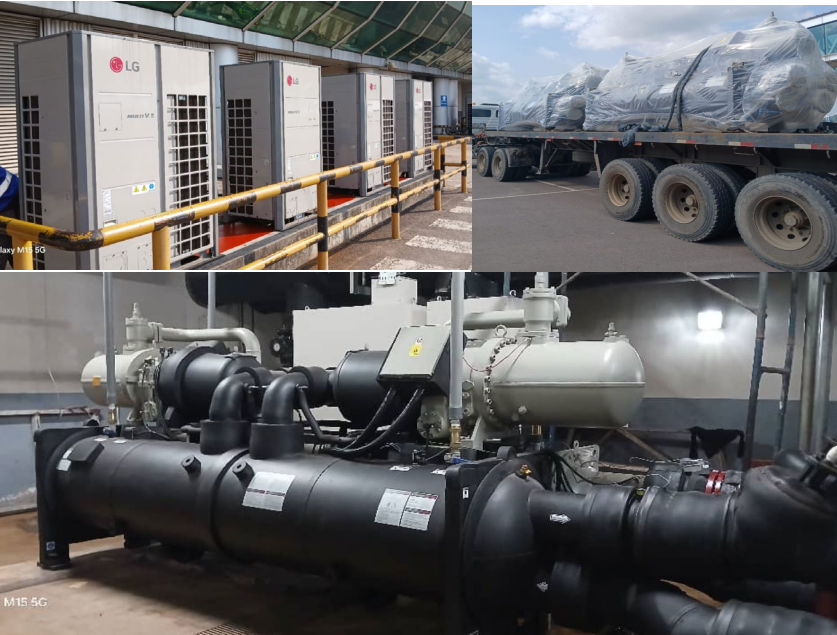
Rénovation climatisation centrale et VRV
