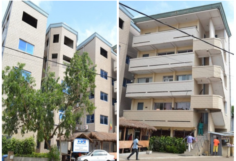
Photo façade avant
